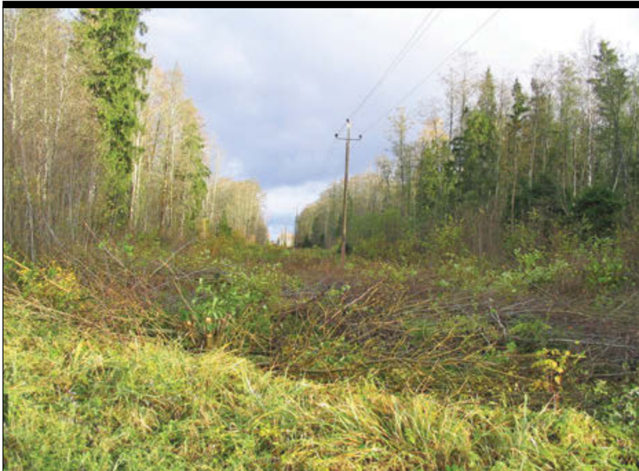
Kui elektriliini alune on võsast puhastatud, ohustavad seda tihti siiski liini ääres kasvavate puude oksad. Elektrilevi katseprojektiga katsetati Aegviidus selliste okste lõikamist helikopterilt.
