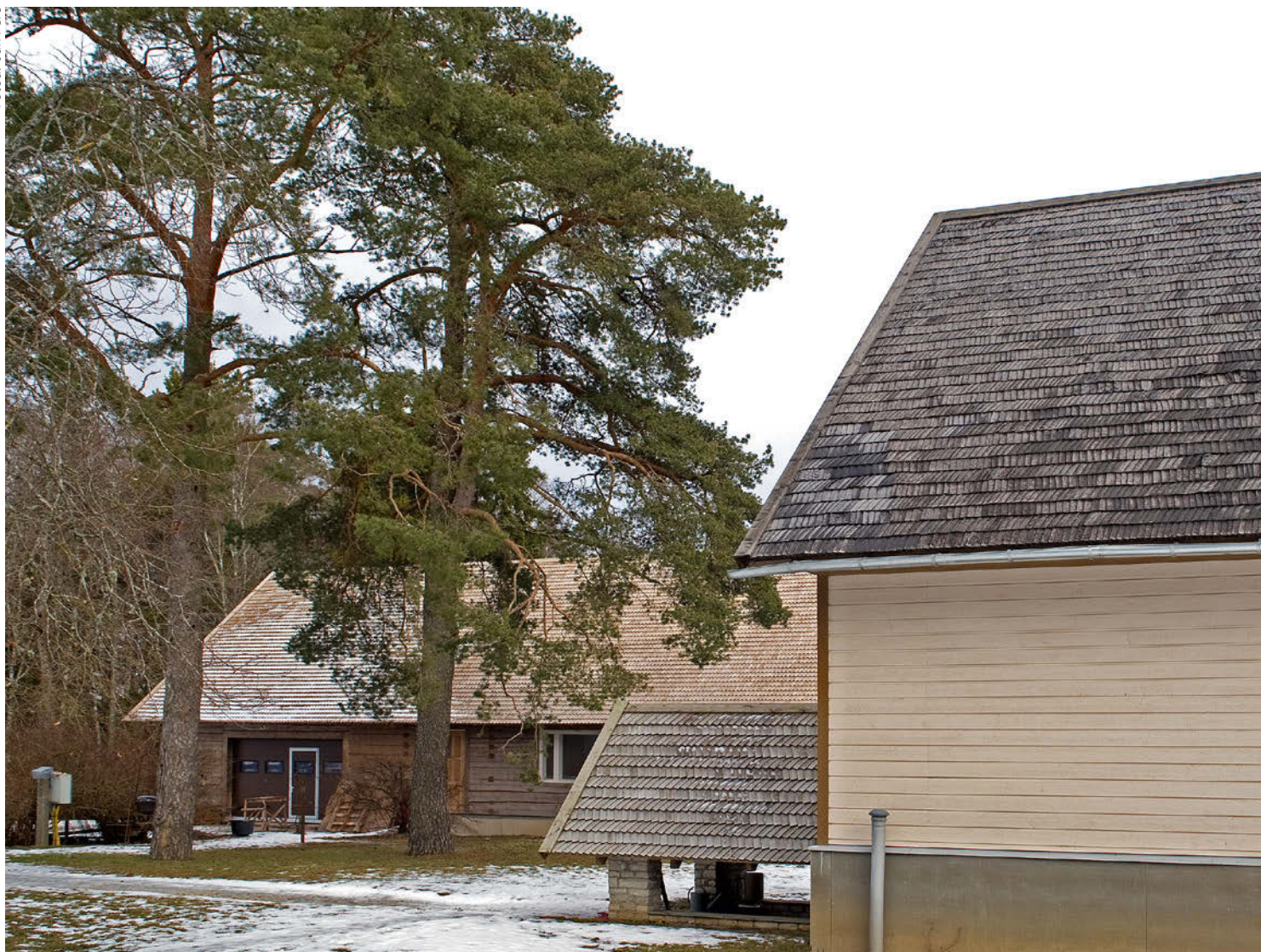
Ants Mattisele kuuluva Lepiku talu katused on kõik Kalev Mõttuse tehtud. Valmimisjärgus elumajale sai peale kimm, saunamajale laast ja selle keldrikatusele sindel.
