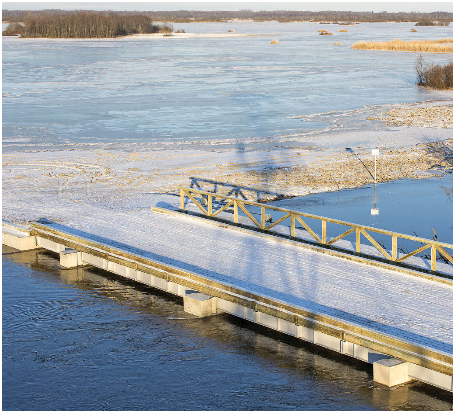
2014. aastal valminud Kloostri sild-regulaator, mis aitab pikendada üleujutusperioodi Kasari lageluhaalal.
