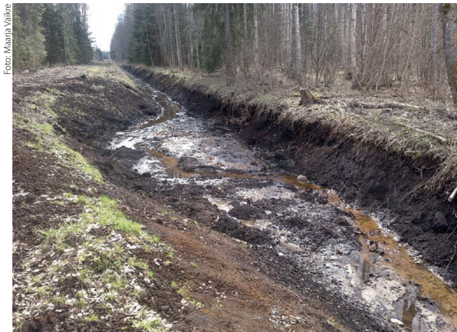
Joonis 4. Ebaõnnestunud kraavilaiend sügavas turbamullas. Kraavi sügavus on 1,8 meetrit. Seetõttu tuleks nõlvade sissevarisemise vältimiseks kraavilaiendite rajamisel eelistada pigem mineraal- kui turbapinnast ja teha laiendid väiksema rekonstrueerimisjärgse sügavusega päikesele avatud kraavilõikudele.
