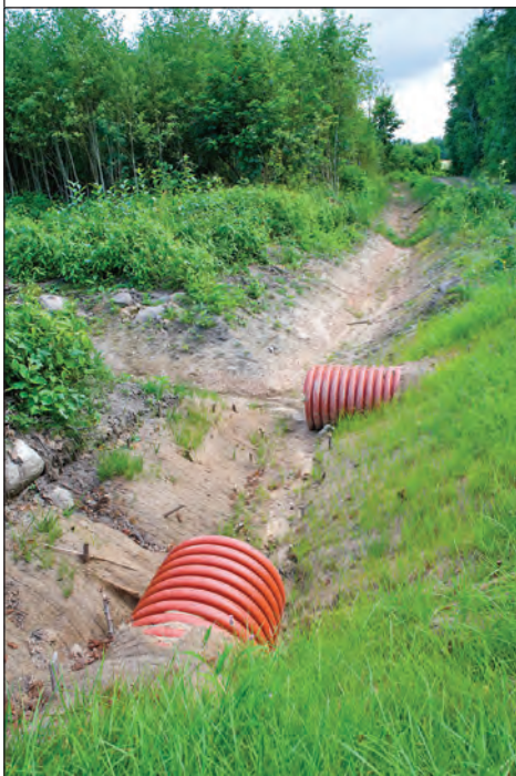
Metsamaa tootlikkuse tõstmiseks rekonstrueeritakse vanu süsteeme, kaevatakse uusi kraave ja rajatakse metsateid.
