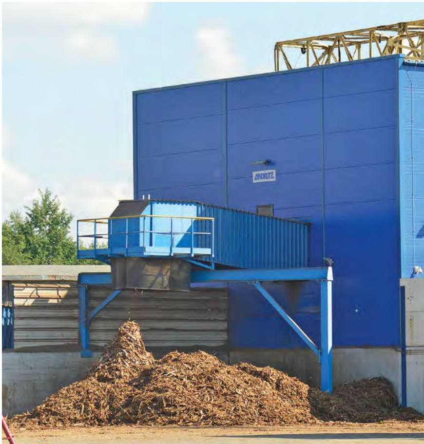
Puidu koorimine on nüüd efektiivsem. Viimane suurem investeering Kehrasse oli nelja miljoni euro paigutamine uue koorimis- ja hakkimisliini soetamise. Varasem liin jättis osa koort tselluloosimassi sisse.
