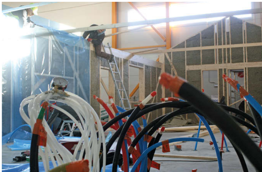
Tehasemajal paigaldatakse elektri ja veeühenduste asukohad juba tootmishoones ja taristuga ühendus tehakse objekti asukohas.
